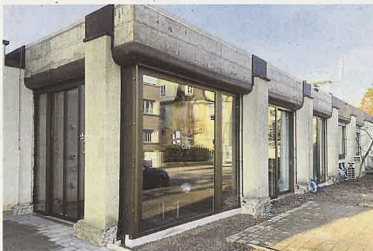
Das neue Zentrum CURA an der Lukas Legrand-Strasse, direkt zwischen Eglisee und Claraspital. (Foto: Werner Blatter)
